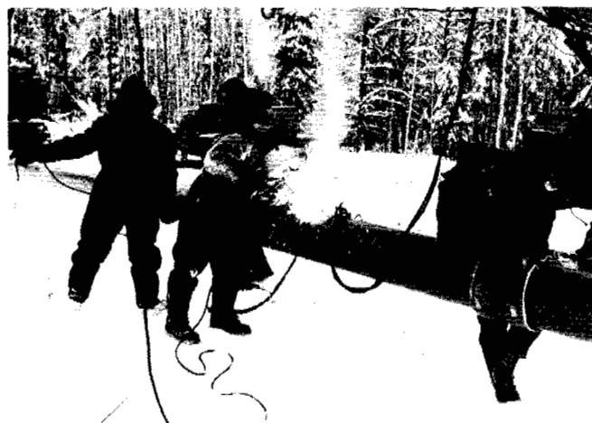
Soudage de deux tronçons de pipeline
