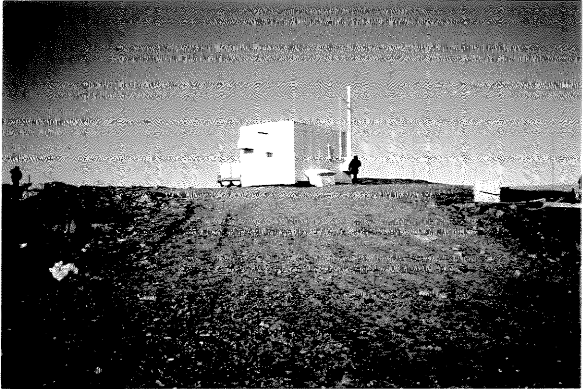
Nouveau site du bâtiment de NAV Canada New site of NAV Canada building
