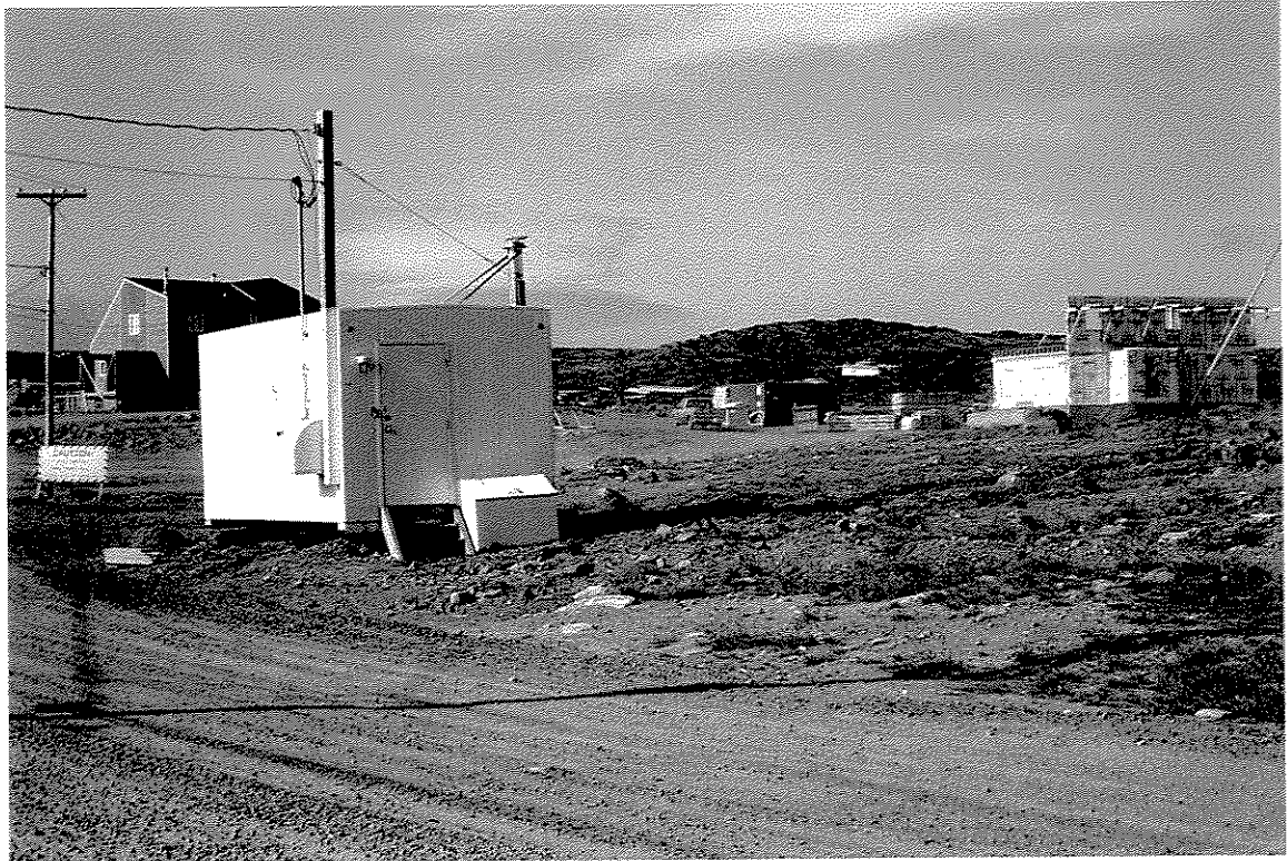
Site de la radiobalise avant le déménagement du bâtiment de NAV Canada Site of the radiobeacon before the moving of NAV Canada building
