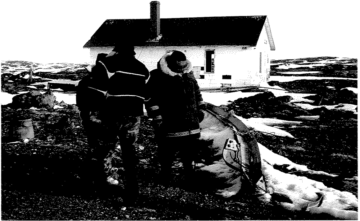
Des antennes écroulées, de vieux équipements rouillés Old antenna lying on the ground and old rusted equipment
