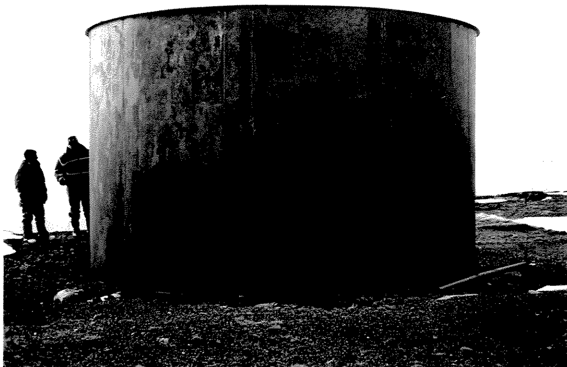
De vieux réservoirs laissés sans entretien Old fuel tanks left without maintenance
