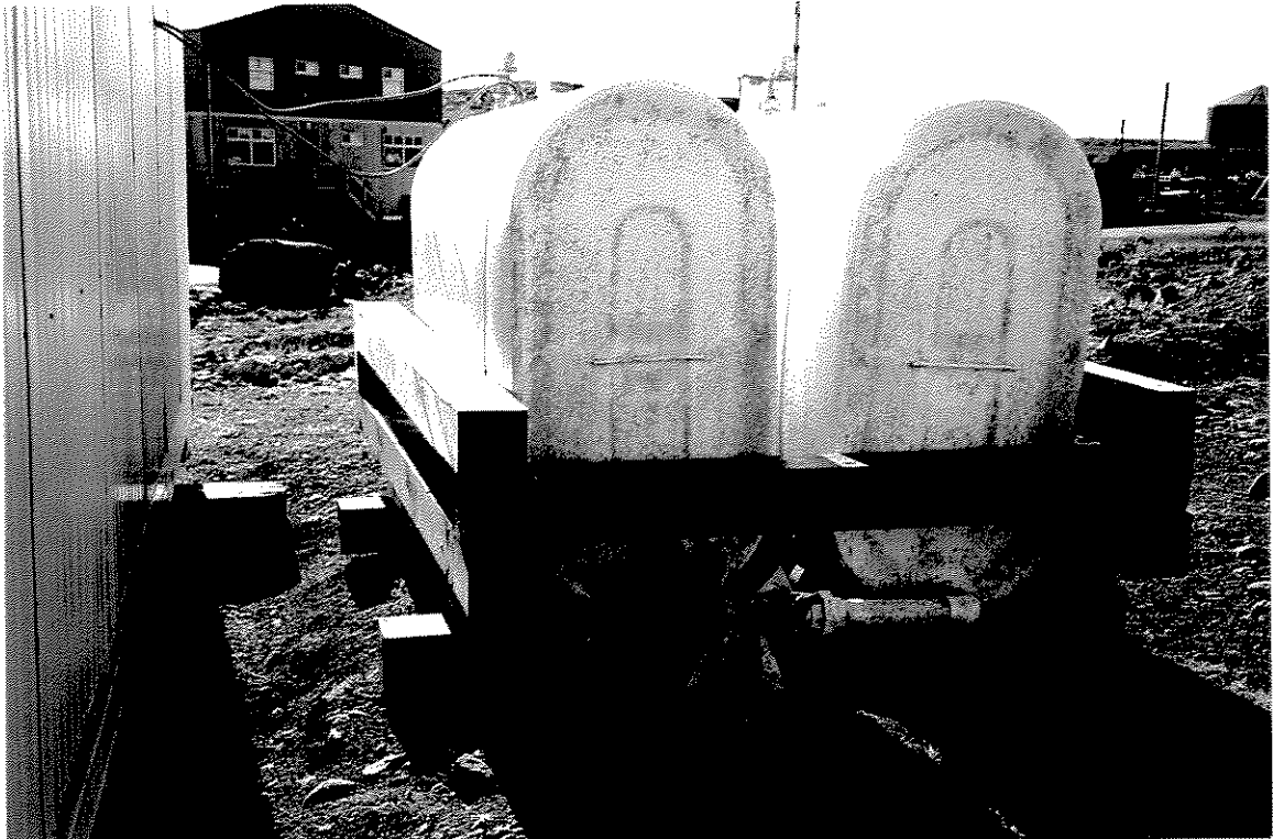
Seule ombre au tableau, les vieux réservoirs de mazout qui alimentent toujours le bâtiment de NAV Canada
