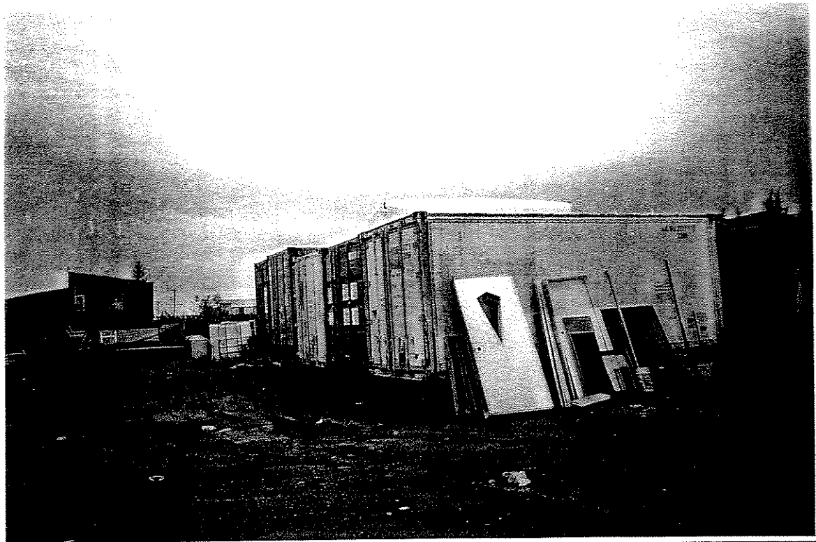
Photo n° 25. Conteneurs d'entreposage – Entrepôts de l'hôpital de Kuujjuaq.
