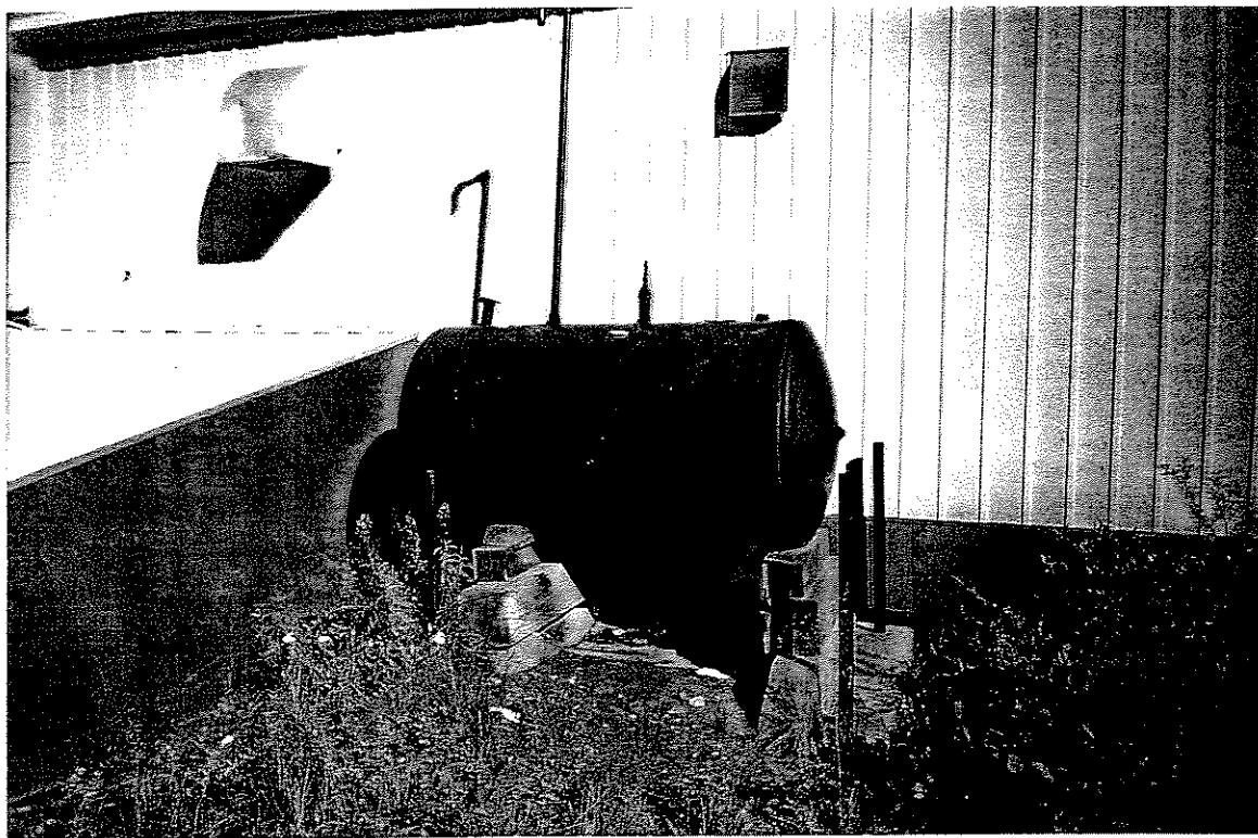
Photo n° 47. Réservoir de mazout 2 273 litres à l'arrière du bureau touristique et de la SRC.
