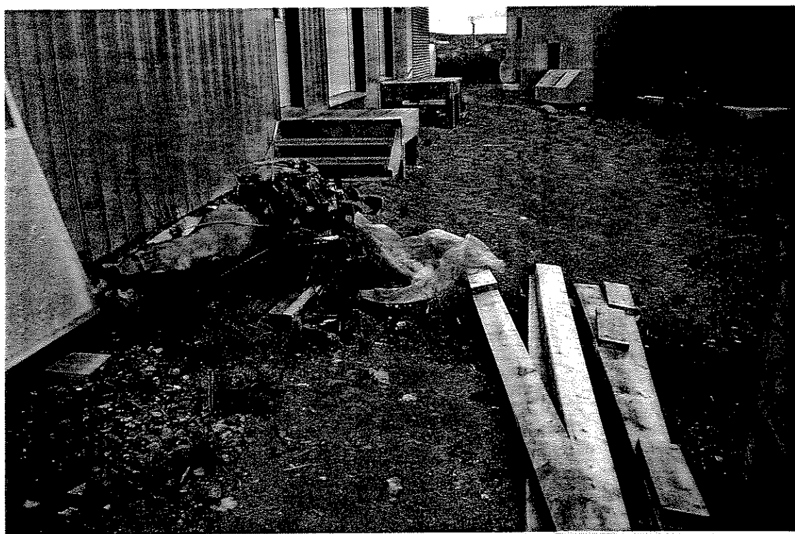
Photo n° 28. Moteur et taches au sol – Entrepôts de l'hôpital de Kuujjuaq.
