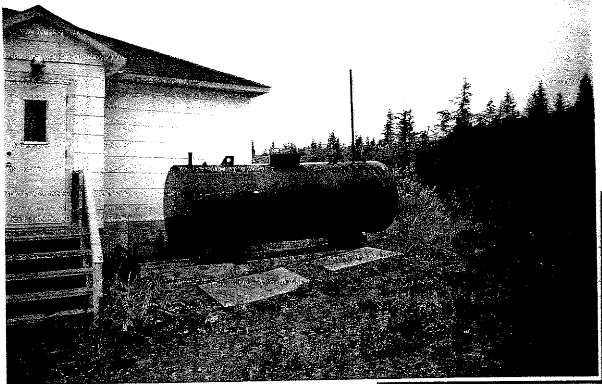
Photo n° 39. Réservoir de mazout 2 273 litres – Centre de désintoxication.
