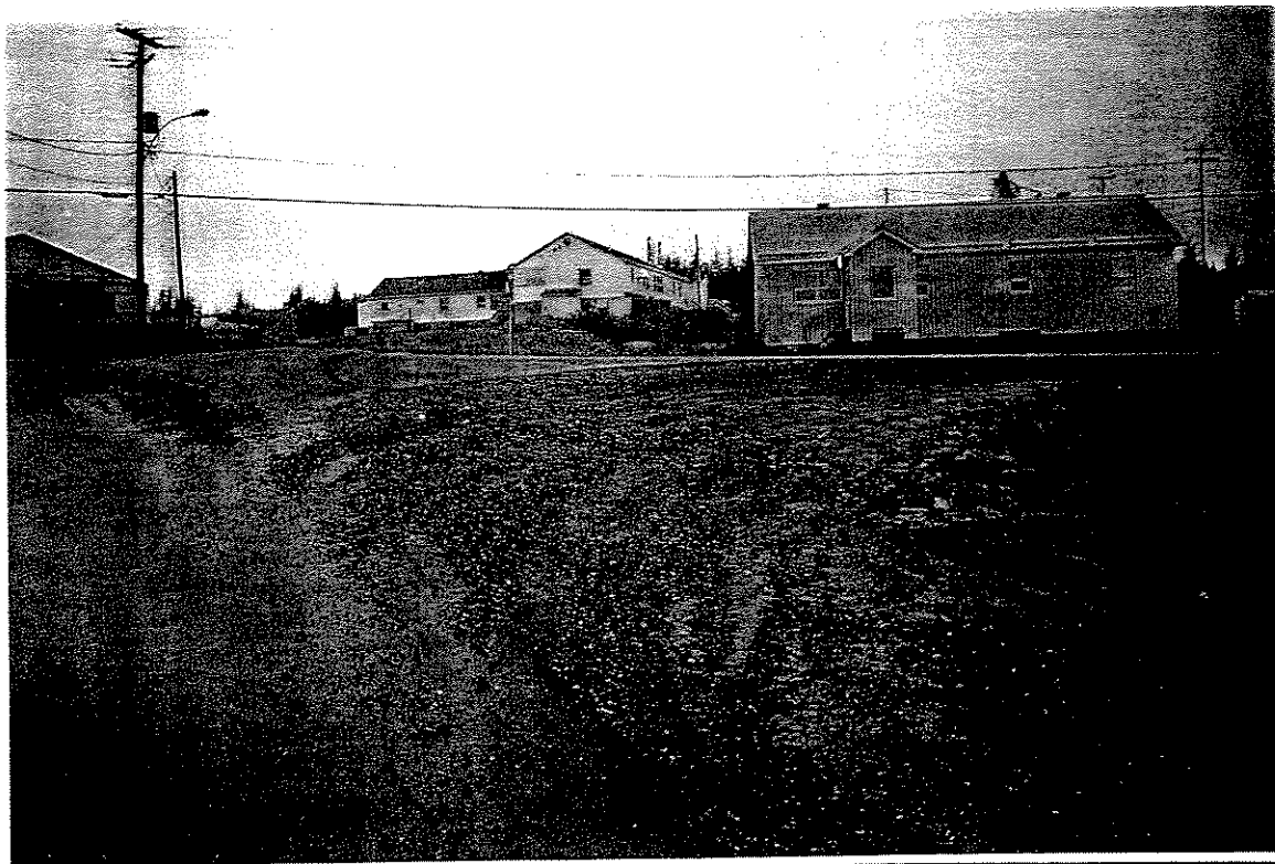
Photo n° 63. Bordure de rue – Parcelle R-12.
