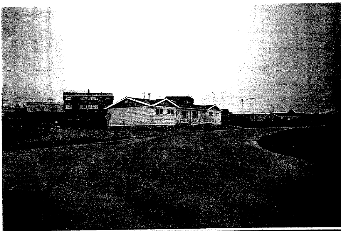
Photo n° 52. Bâtiment résidentiel – Parcelles A-5 et C-13.
